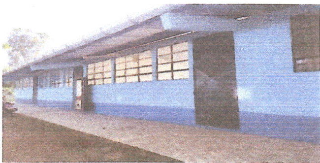
Foto 5: Aplicación de pintura en los muros exteriores del centro educativo.
