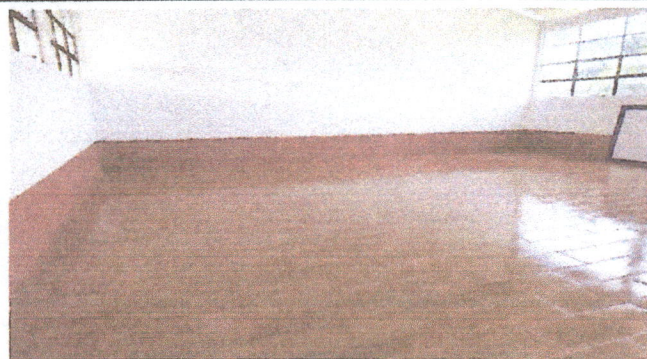
Foto1: Insatlación de piso cerámico tipo dueñas, en las aulas del centro educativo.
