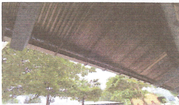
Foto 4: Instaaación de canal tipo americano en el modulo de preprimaria.
