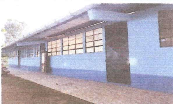
Foto 2: Instalación de piso cerámico anti-deslizante en el corredor del modulo de preprimaria.
